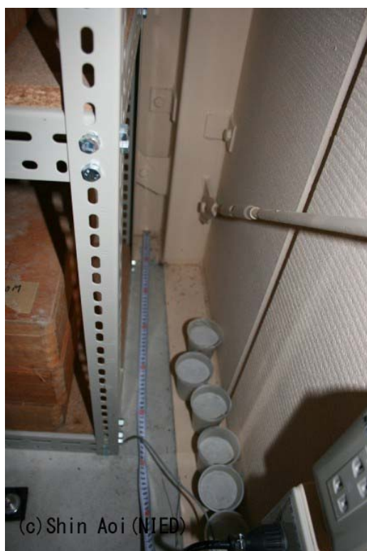
写真1 : (a) 軽量棚の設置状況の遠景及び(b)そのズームアップ。青丸で示した部分は、通信回線が軽量棚に挟まれ切断した様子を示す。左側に見えるのは断線した片割れのケーブル。
