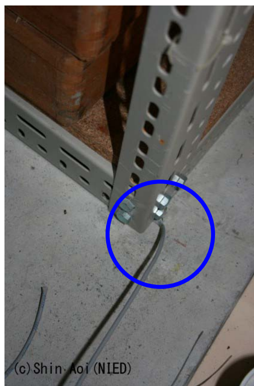
写真1 : (a) 軽量棚の設置状況の遠景及び(b)そのズームアップ。青丸で示した部分は、通信回線が軽量棚に挟まれ切断した様子を示す。左側に見えるのは断線した片割れのケーブル。
